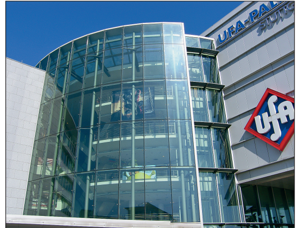
Technik und Ästhetik: Die Glasfassade des Stuttgarter Ufa-Palastes wird von gebo Punkthaltersystemen getragen, die in Neckarwestheim entwickelt und hergestellt werden.
