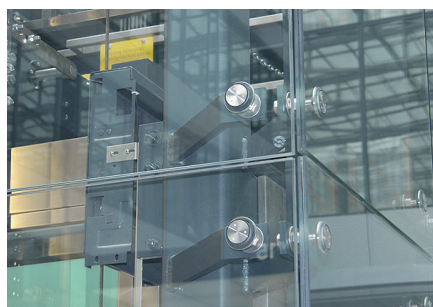
Elf Aufzugschachtverglasungen sind punktgehalten ausgeführt.
