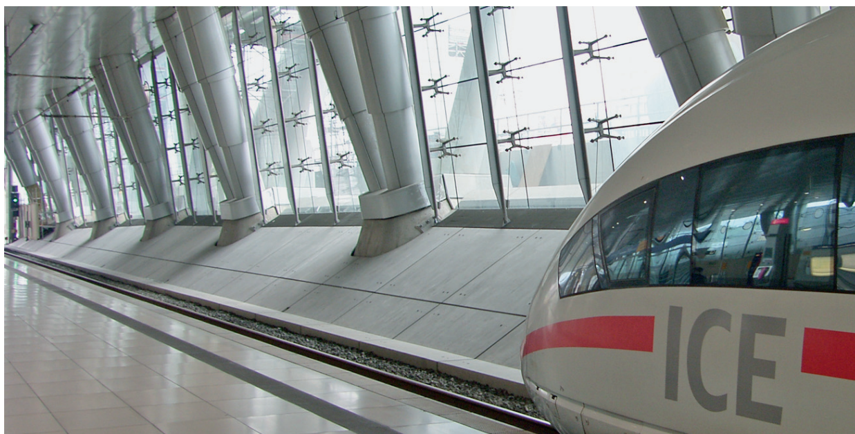
Punktgehaltene Glasfassaden kennzeichnen das Airrail Squaire Frankfurt.
