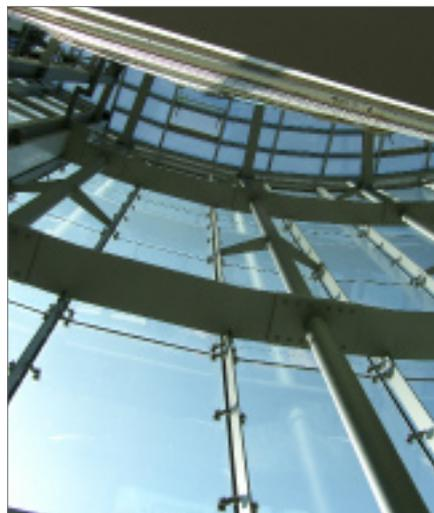
Wesentlich für die Ausführung einer punkthaltigen Verglasung ist die richtige Auswahl der Konstruktionsteile in Bezug auf Technik und Qualität.
