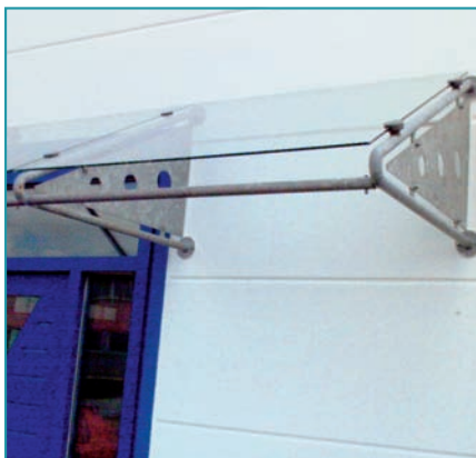
Manchmal werden punktgehaltene Glasdächer ausgeführt, die bestimmt durch kein Genehmigungsverfahren gegangen sind (Abb. links, Systemglasvordach (!) mit Mini-Punkthalter mit \varnothing 30 mm, Abb. mitte, Glasdach mit Geländerglashalter, Abb. rechts, Glasdach mit Kunststoffbuchse und Unterlegscheiben).
