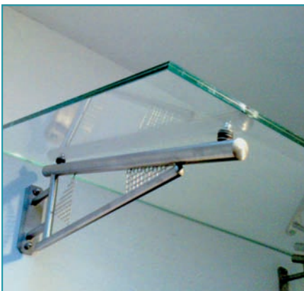
Manchmal werden punktgehaltene Glasdächer ausgeführt, die bestimmt durch kein Genehmigungsverfahren gegangen sind (Abb. links, Systemglasvordach (!) mit Mini-Punkthalter mit \varnothing 30 mm, Abb. mitte, Glasdach mit Geländerglashalter, Abb. rechts, Glasdach mit Kunststoffbuchse und Unterlegscheiben).
