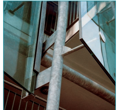
Mischlagerungen aus linienförmiger Auflage und Punkthaltern erfordern besondere Betrachtungen
