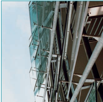
Punktgehaltene Glaskonstruktionen kommen um eine Zustimmung im Einzelfall nur selten herum.
