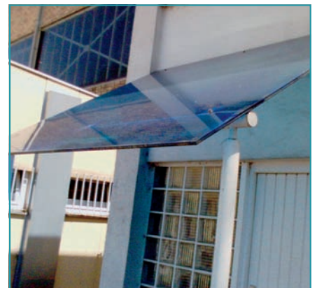
Manchmal werden punktgehaltene Glasdächer ausgeführt, die bestimmt durch kein Genehmigungsverfahren gegangen sind (Abb. links, Systemglasvordach (!) mit Mini-Punkthalter mit \varnothing 30 mm, Abb. mitte, Glasdach mit Geländerglashalter, Abb. rechts, Glasdach mit Kunststoffbuchse und Unterlegscheiben).
