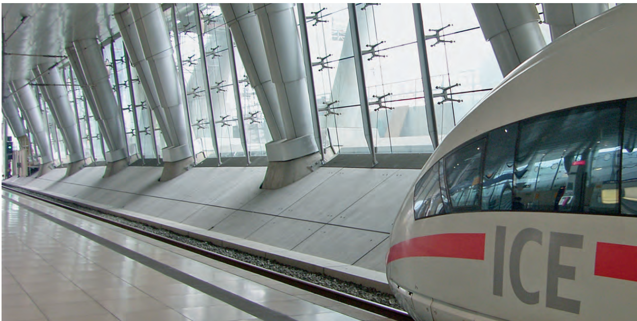
Punktgehaltene Glasfassaden kennzeichnen das Airrail Sqaire Frankfurt.
