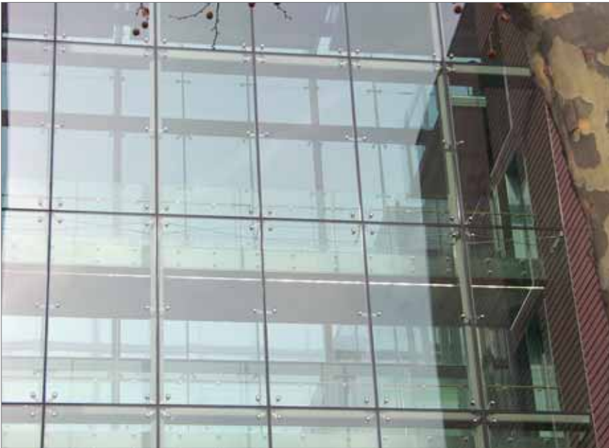
Isolierglassenhalter ZK CI von Gebo kamen bei der Allianz Frankfurt zur Anwendung.
