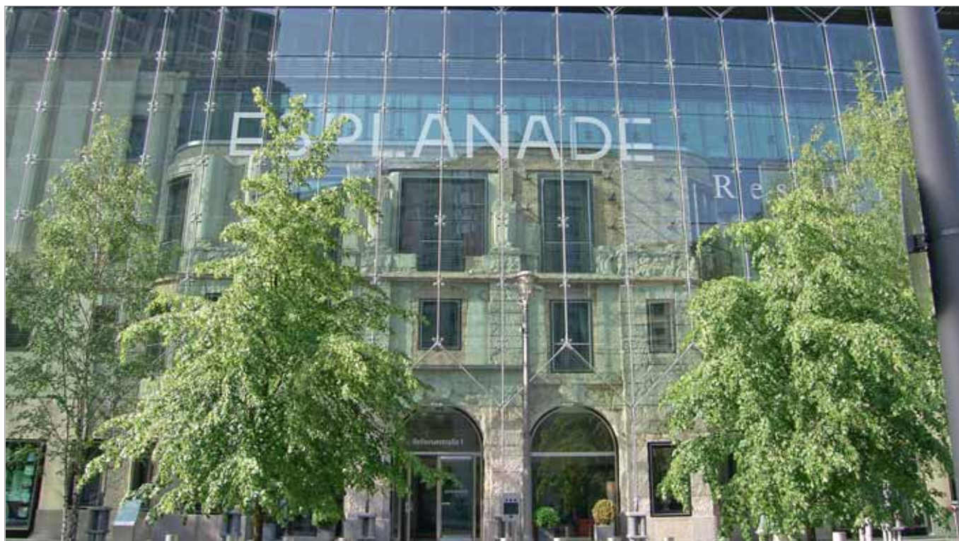
Bei der Konstruktion der Glasfassade am Esplanade Sony Center in Berlin sind Monohalter ZK CA von Gebo mit Sonderspider eingebaut.
