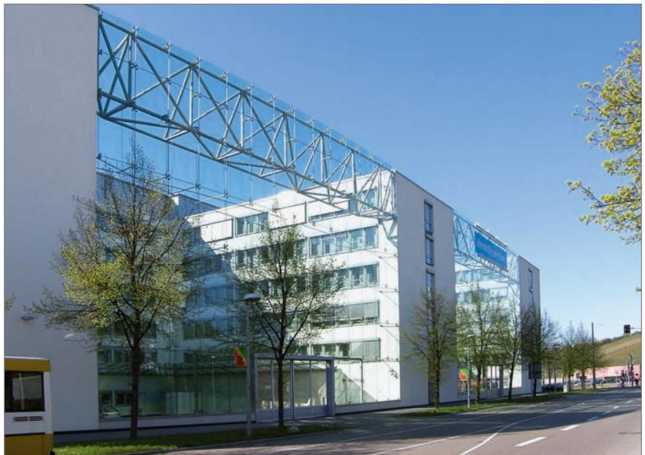
Architekten entwerfen und planen filigrane Stahlkonstruktionen mit punktgehaltenen Verglasungen, um eine schwerelos wirkende, ästhetisch wie technisch anspruchsvolle transparente Konstruktion zu realisieren.
