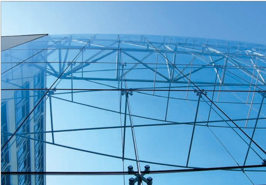
Gebo Punkthalter ermöglichen planmäßig einen optimalen Toleranzausgleich, um die Glasseiben unter Berücksichtigung der baupraktischen Toleranzen zwängungsfrei zu montieren.
